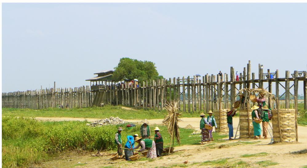
**Bei der längsten Teakholzbrücke der Welt sollen Teile der mehr als 150 Jahre alten Stämme ausgetauscht werden. Geplant ist, das alte Holz entweder als Handläufe oder Sitzbänke an der Brücke weiterhin zu nutzen.** © Fraunhofer WKI/Peter Meinschmidt | Bild in Farbe und Druckqualität: [www.fraunhofer.de/presse](http://www.fraunhofer.de/presse).
